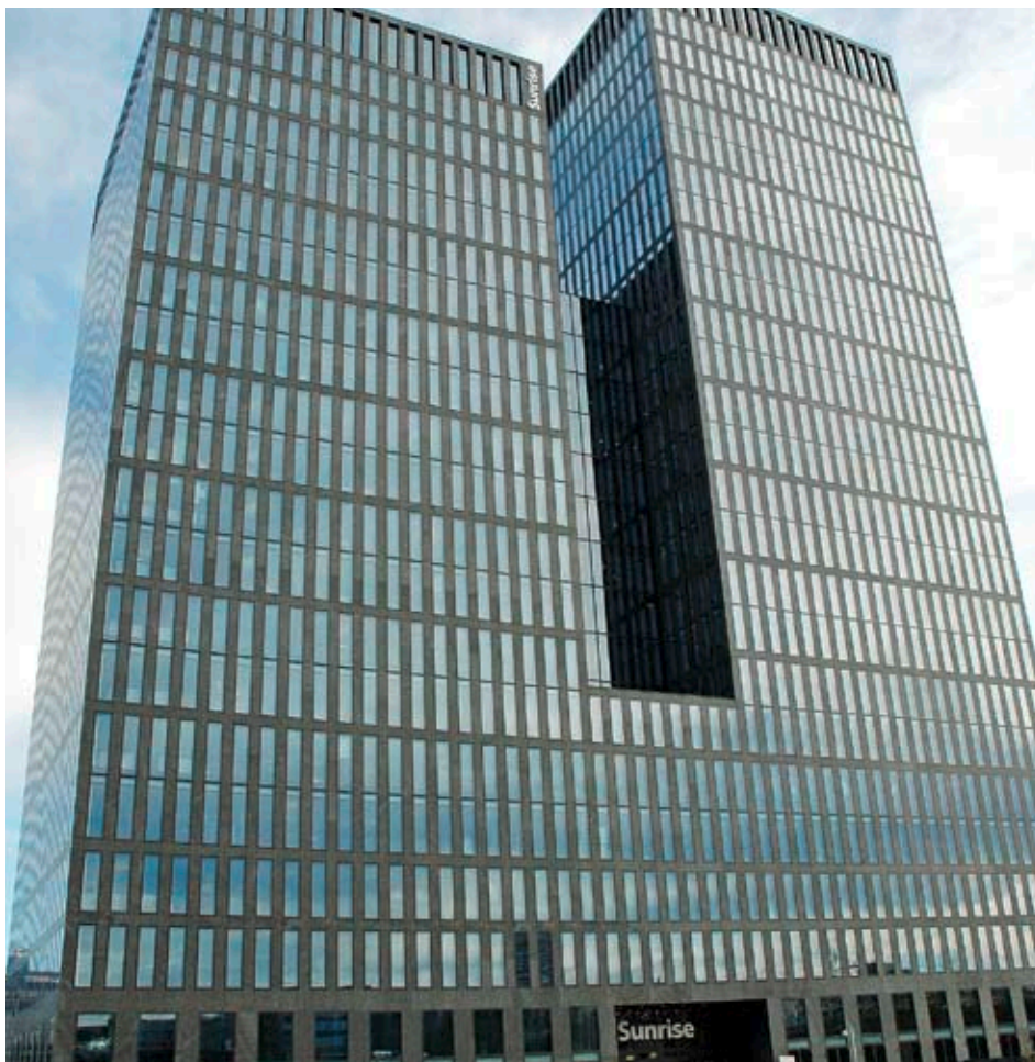
Wettervorhersagen regeln Heizung und Kühlung im «Sunrise Tower».
