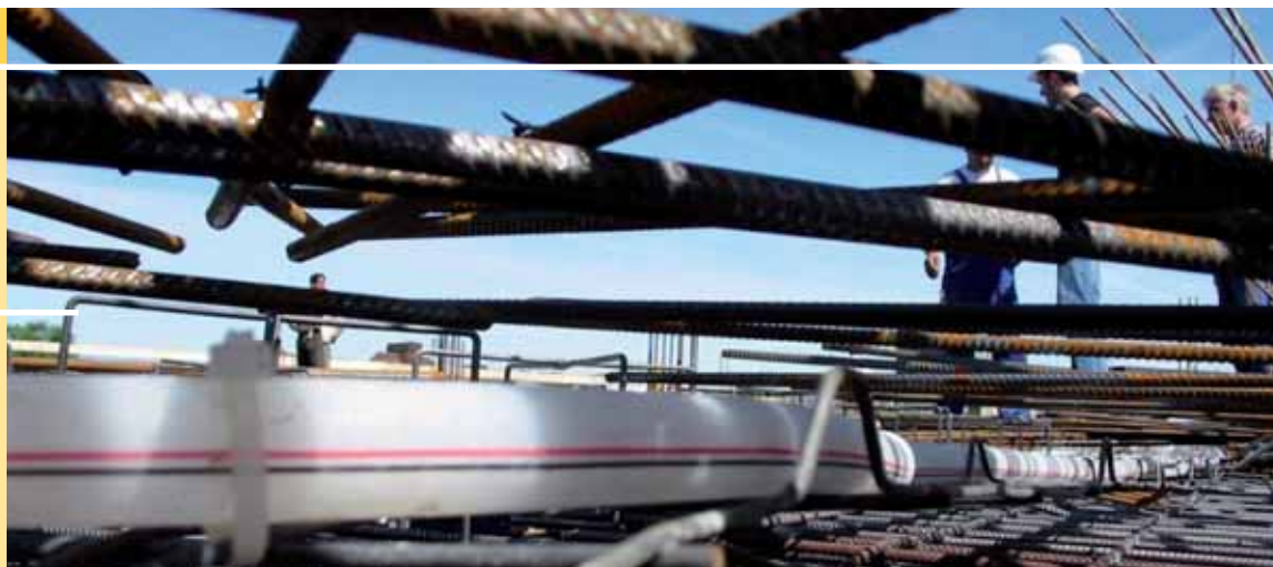
Abb. 7 Im Kern des zukünftigen Betons: Zwischen oberer und unterer Bewehrung fixierte Rohrleitung. Foto: solares bauen GmbH
