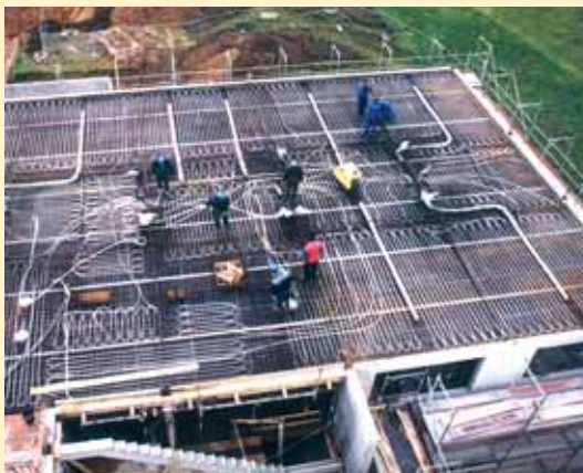
Abb. 25 Blick auf eine Geschossdecke mit den BKT-Rohrregistern in der Bewehrung und den weißen Lüftungsrohren. Foto: VIKA Ingenieur GmbH
