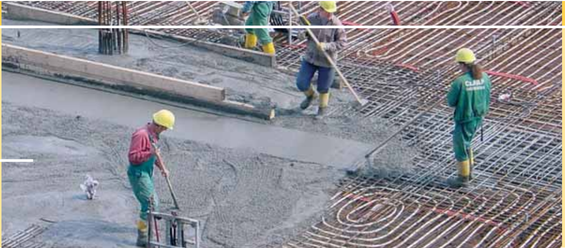
Abb. 14 Nach dem Verlegen der Bewehrung und der Rohrmatten gehen die Betonierarbeiten zügig voran. Foto: Heinle, Wischer und Partner (Bauleitung Post-Tower)
