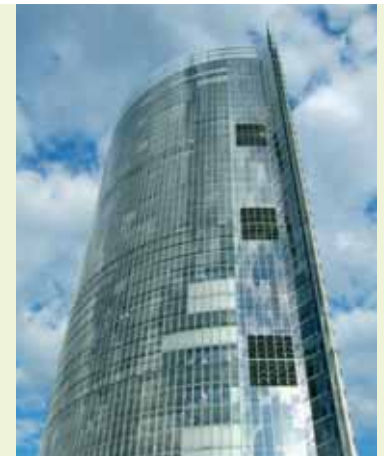
Abb. 5 Das höchste Bürogebäude in Nordrhein-Westfalen wird energieeffizient gekühlt – mit thermoaktiven Bauteilsystemen. Foto: BINE Informationsdienst
