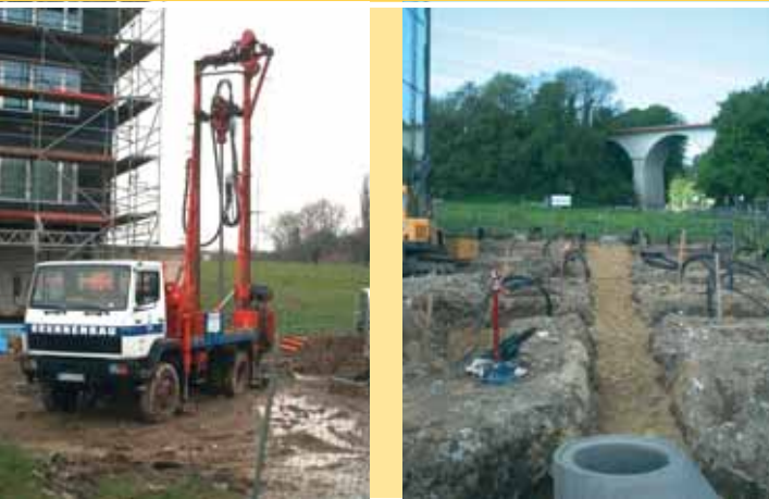
Abb. 16 Erdwärmesonden in der Realisierung (Gebäude BOB Aachen). Fotos: Fachhochschule Köln und VIKA Ingenieur GmbH
