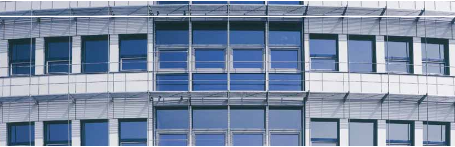
Abb. 1 Thermoaktive Bauteilsysteme kühlen und heizen das Bürogebäude Energon in Ulm. Foto: Software AG Stiftung, Darmstadt
