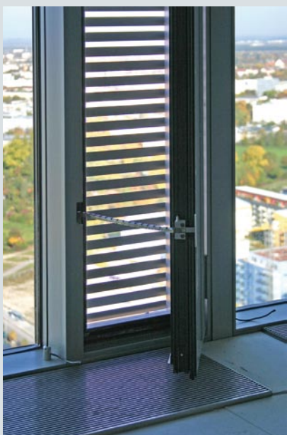
Nowcasting: Mit den entsprechenden Informationen kann das Gebäudeautomations-system bei drohendem Unwetter z. B. die Fenster automatisch schließen.
