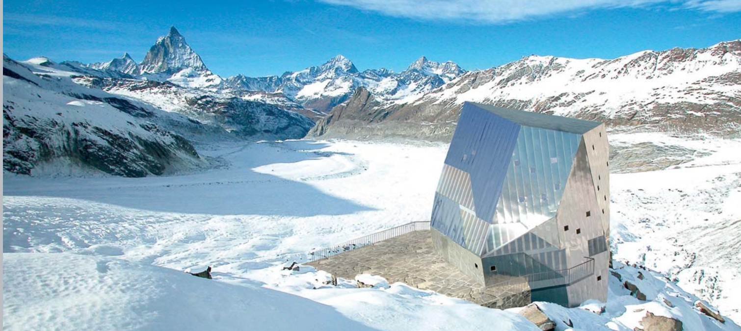
Abb. 1: Neue Monte Rosa Hütte: ein Projekt der ETH Zürich anlässlich ihres 150-jährigen Bestehens und experimentelles Vorzeigebauwerk für modernste Gebäudetechnik. Foto: Siemens Switzerland Ltd. 2007
