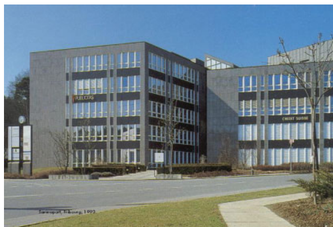
Bild 6. Erstes kommerzielles Gebäude mit Quellaftung und TAB (Strahlungsheizung und -kühlung) der Schweiz (und Europas?), thermischer Energiebedarf < 34 \text{ kWh/m}^2\text{a} , in Betrieb seit 1991
