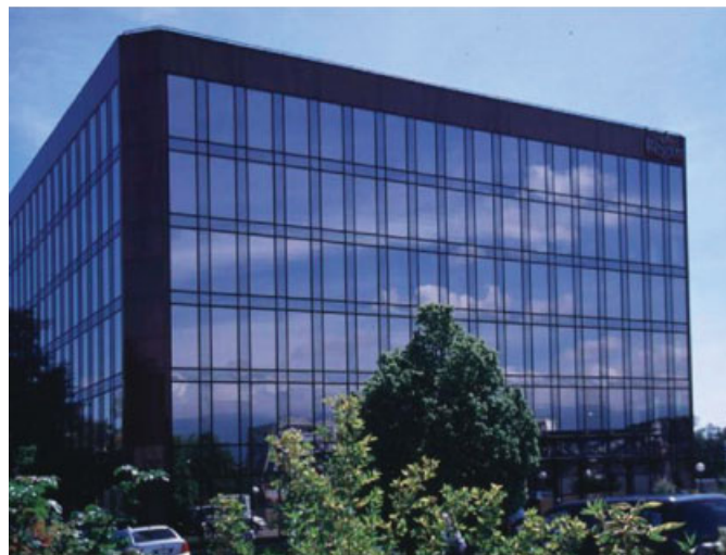
Bild 5. Das erste (kommerzielle) „3-l“-Gebäude ( E_w = 27 \text{ kWh/m}^2\text{a} ) Europas in Genf, in Betrieb seit 1985
